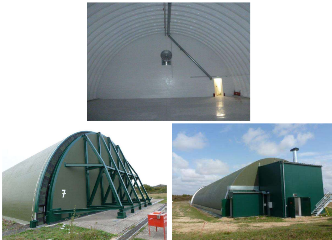
Figure 27 : vues intérieures et extérieures de la hangarett 0086 (HG7) [photos ESID]
