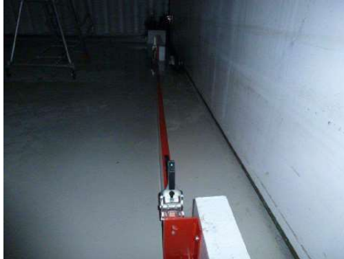
Figure 28 : barrière étanche amovible mise en place au niveau de la porte d'accès principale de la hangarette 0086 (HG7) [photo ESID]
