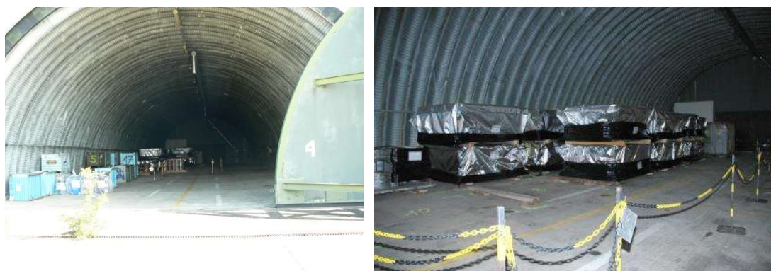
Figure 26 : entreposage de déchets radioactifs dans la hangarette 0025 (HG4) [photos ESID/EAR 279]
